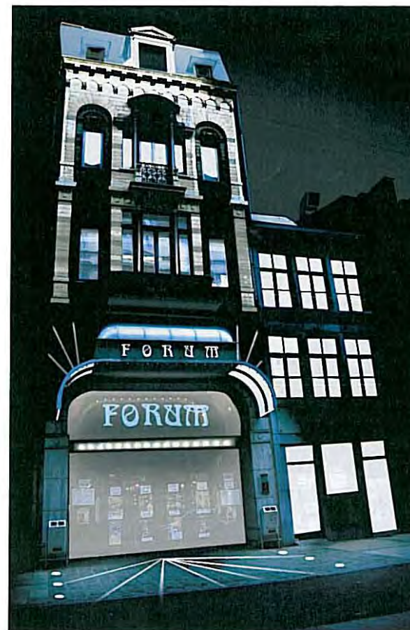
15. Illumination de la façade (projet 2008).
