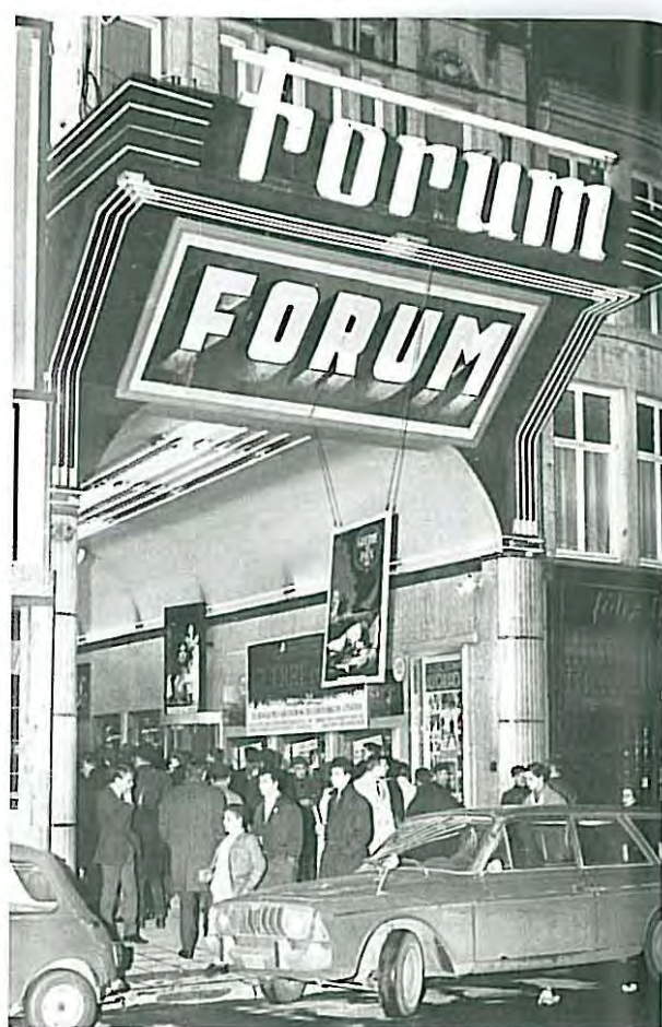
14. Façade à la fin des années '50.
